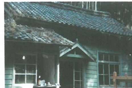
旧つくばね発電所
